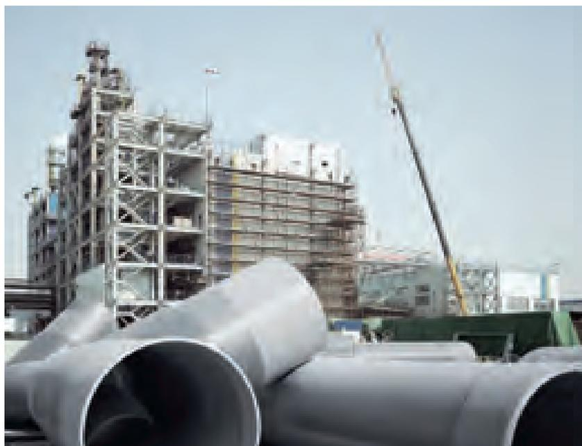
Blick auf die zweite Ausbaustufe der Produktionsanlagen für pyrogene Kieselsäuren im Werk Zhangjiagang. Gebäude und Stahlbau sind weitgehend fertiggestellt, die Montage von Apparaten und Rohrleitungen läuft mit Hochdruck.
