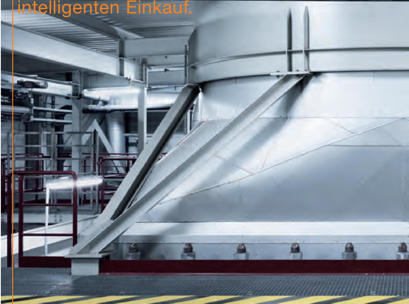
Abhitzeessel über der Turbine im modernen Gas- und Dampfkraftwerk am Standort Burghausen. Die Gasturbine liefert nicht nur ein Drittel des im Werk benötigten Stroms, mit ihrer Abwärme wird auch Prozessdampf für die Chemieproduktion erzeugt. Der hoch gespannte Dampf treibt seinerseits weitere Turbinen zur Stromerzeugung an. Ein perfekter Kreislauf, der höchste Wirkungsgrade liefert, Kosten senkt und Ressourcen schont.
