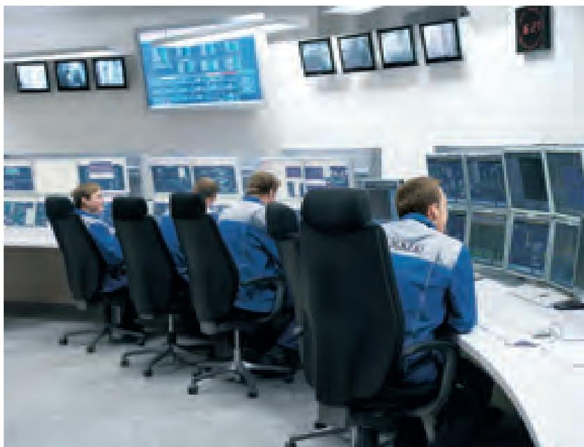
Die Messwerte des Gas- und Dampfkraftwerks im Werk Burghausen. Über ihre Leitreechner steuern die Mitarbeiter die Dampferzeugung.
